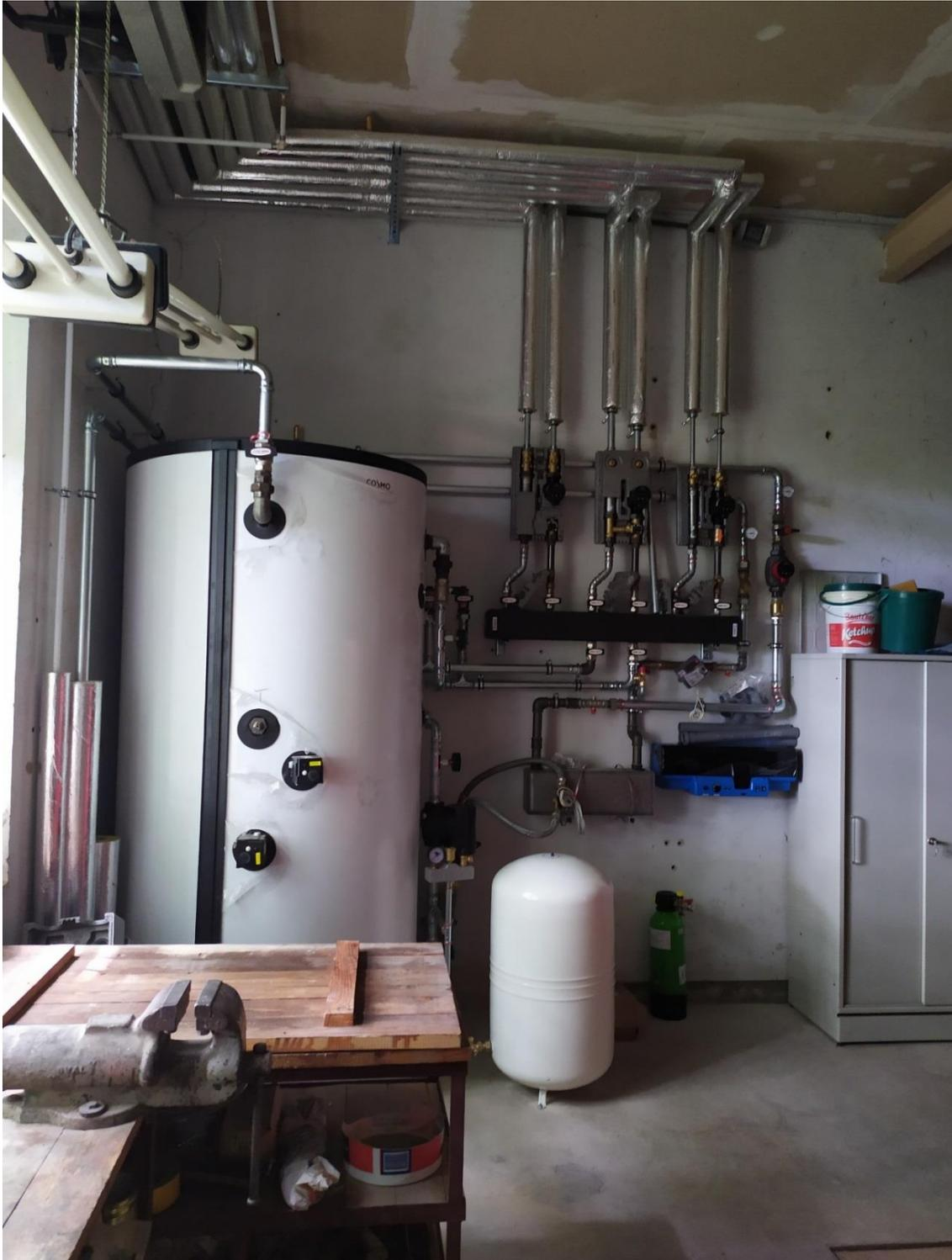
Neue Heizungsanlage mit Pufferspeicher
