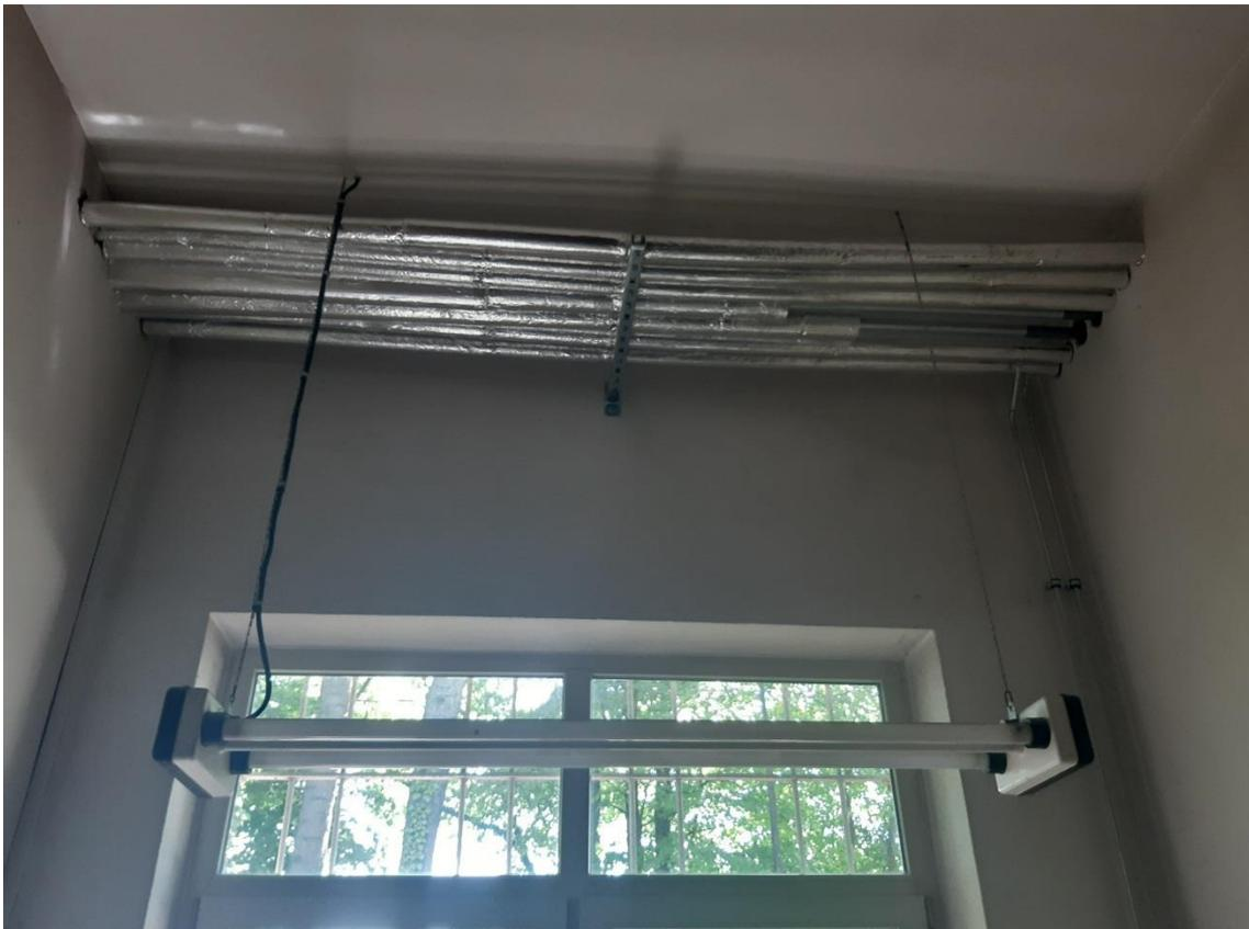
Verlegung der neuen Heizleitungen an der Gebäudedecke
